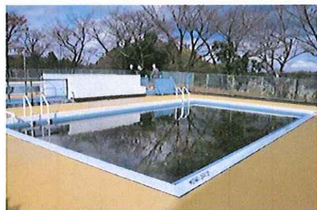
小学校 小プール
