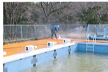
高圧ジェット洗浄の状況(ハンドガン)
