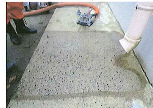
コンクリート表面除去状況
