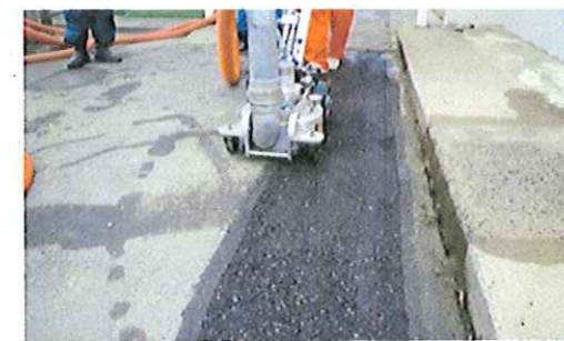
アスファルト表面除去状況
